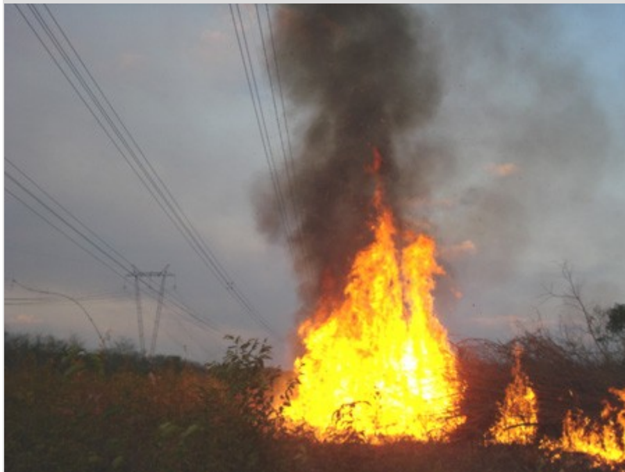
Queimadas no interior do Estado atingem linhas de transmissão da Chesf
