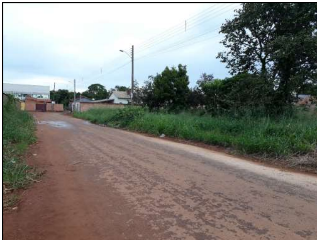
Fotografia 16: Rua 01 do bairro Setor Lagoa da Ilha, com pavimentação asfáltica, rede elétrica, lotes lindeiros abertos e residências.
