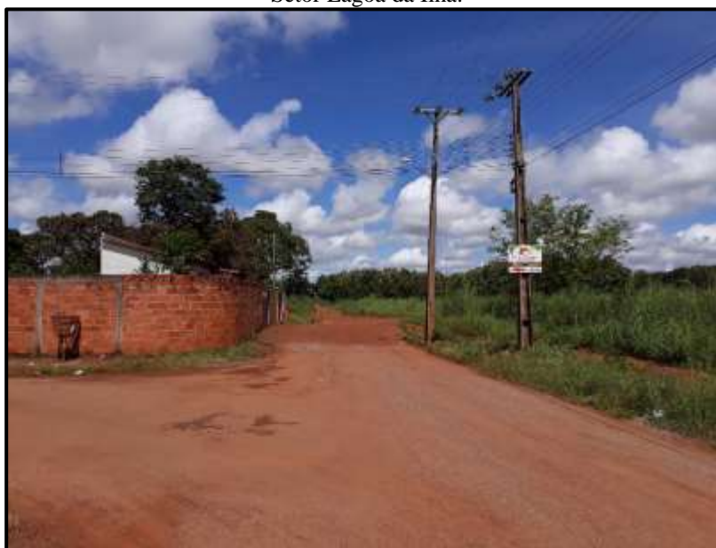
Fotografia 2: Final da pavimentação asfáltica da Avenida LO-01, localizada na porção centro-norte do bairro Setor Lagoa da Ilha.
