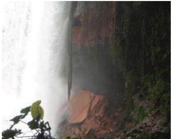
Figura 153 - Queda de bloco de grande dimensão na cachoeira da Fumaça. Fotografia: Yukie Kabashima, 2011.
