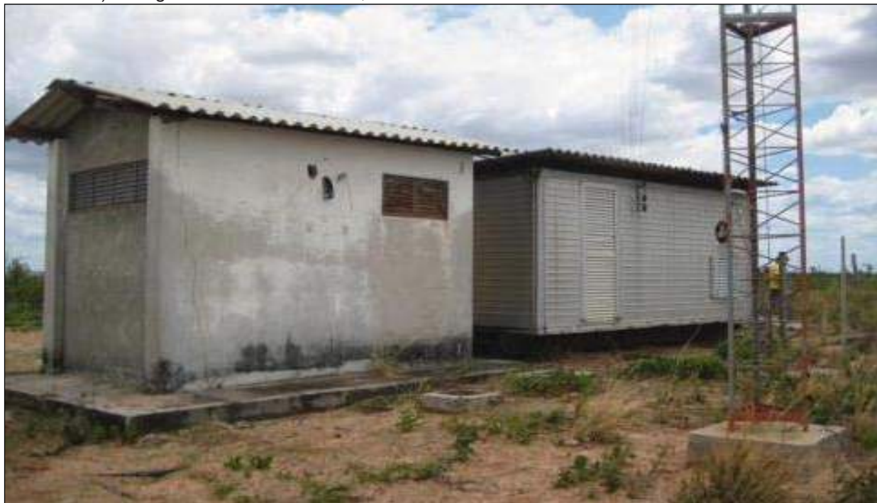
Figura 117 - Equipamentos da operadora de telefonia Oi localizados na serra da Piabanha (S11°23'56" e W46°53'32"). Fotografia: Yukie Kabashima, 2011.
