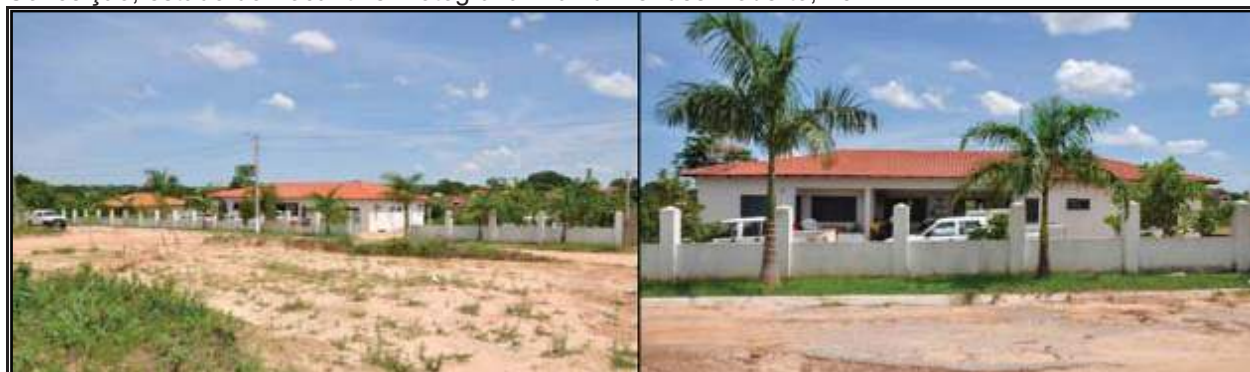
Figura 171 - Sede da Estação Ecológica Serra Geral do Tocantins, localizada no centro de Rio da Conceição, estado do Tocantins. Fotografia: David Mendes Roberto, 2011.
