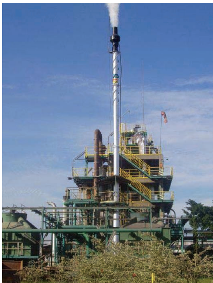
Foto 2 - Incinerador da Haztec-Tribel em Belford Roxo/RJ 14
