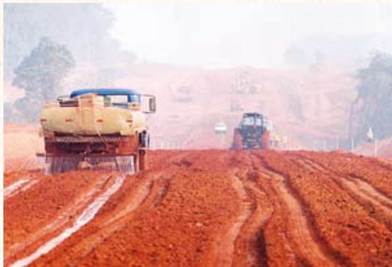
Mato Grosso - Asfalto della BR Cuiabá – Juína Mato Grosso - Asfaltamento da BR Cuiabá - Juína
