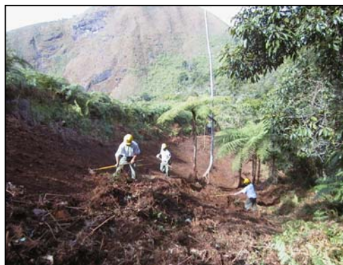
Construção de Aceiros
