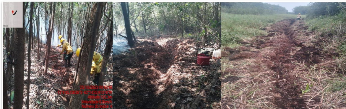
Trabalho na frente de combate 02 - Abertura de trincheira na turfa
